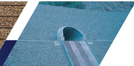
Parement incliné en treillis - ArmaStone®
