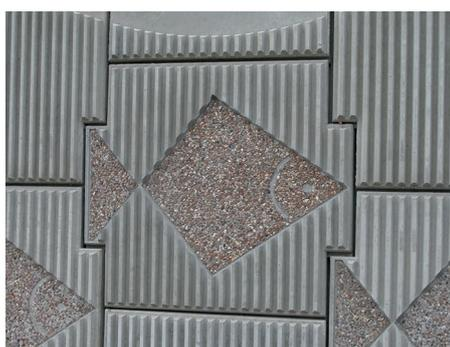
L'aspect des panneaux en béton préfabriqué peut être amélioré en utilisant des revêtements de coffrage architecturaux standard ou personnalisés. D'autres caractéristiques esthétiques peuvent être obtenues par des traitements spécifiques du béton, tels que la coloration ou des granulats apparents.
