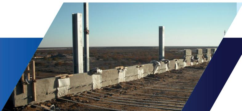
Les armatures en acier HA constituent la solution idéale pour des charges statiques et dynamiques élevées et le seul choix raisonnable pour les ouvrages sensibles, tels que les murs de très grande hauteur, les culées de pont, l'exploitation minière lourde, les murs de soutènement industriels ou les ouvrages supportant des voies ferrées.
