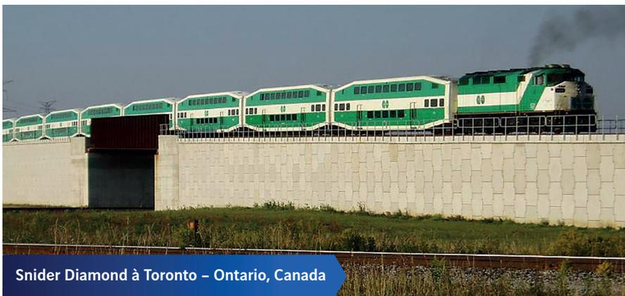
L'élargissement des remblais ferroviaires peut être effectué avec des ouvrages Terre Armée® construits le long du remblai existant ou sur celui-ci.
