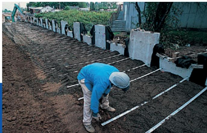
Les armatures à haute adhérence (ou **armatures en acier HA**) présentent des nervures perpendiculaires à leur axe sur les deux faces et un trou de boulon à une extrémité pour la fixation au parement. C'est de loin l'armature la plus largement utilisée pour une structure Terre Armée®, avec plus de 40 millions de mètres carrés d'ouvrages construits dans le monde entier.
