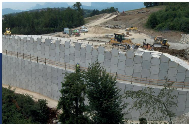
Outre les engins classiques de terrassement, nécessaires à la mise en place du remblai, il faut prévoir une grue légère pour la manutention des panneaux, dont le poids varie de 0,8 à 2,0 tonnes pour les panneaux courants de 14 cm d'épaisseur.
