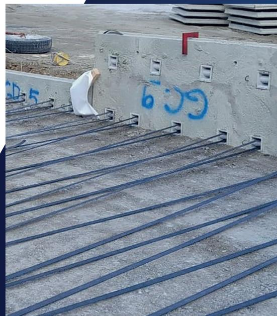
Terre Armée®, largement utilisée dans le monde entier, est bien adaptée à la réalisation des soutènements de toutes natures en site terrestre ou immergé : murs, culées de pont, stockages, merlons de protection...
